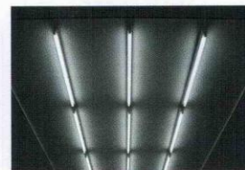
Система светодиодного освещения позволяет экономить электроэнергию в 10-15 раз по сравнению с лампами накаливания и в 2-3,5 раза по сравнению с энергосберегающими лампами.
