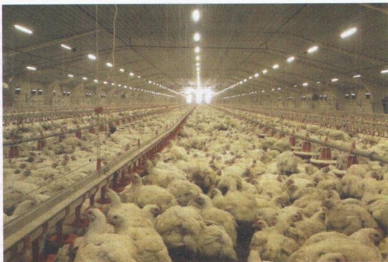
Рис. 62. Светодиодное освещение «ТЕХНОСВЕТ ГРУПП» в корпусе 18×96 метров напольного выращивания цыплят-бройлеров на предприятии ГАП «РЕСУРС»
