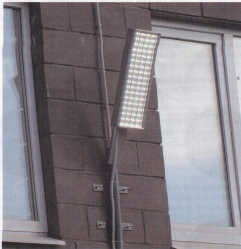
Рис. 65. Уличный светильник мощностью 70 Вт и световым потоком 8 000 Лм
