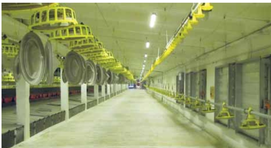
Рисунок 1. Корпуса для содержания родительского стада, 18x120 м. Система светодиодного освещения ИСО «Хамелеон», состоящая из 134 светильников СН1050-20-120-Т при высоте подвеса 2,7 м обеспечивает уровень освещенности 90-95 лк.
