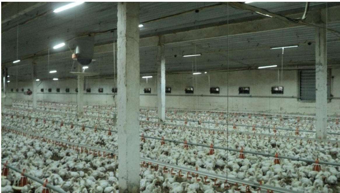
Рис.6 Корпуса напольного содержания бройлеров на площадке Балахоновская. Светодиодные системы освещения ИСО «Хамелеон» установлены в сентябре-октябре 2009 года. Уровень освещенности в среднем 45-46 люкс. Цветовая температура 5500 К.
