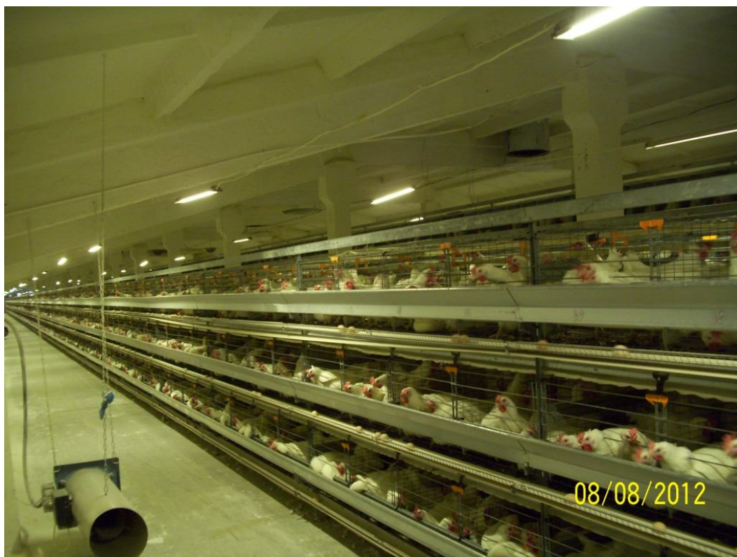
Рис.3 Корпуса клеточного содержания ремонтного молодняка размерами 18X132 метра. Светодиодные системы освещения ИСО «Хамелеон» установлены в апреле 2011 года. Уровень освещенности на нижней кормушке 60 люкс. Цветовая температура 3500 К.
