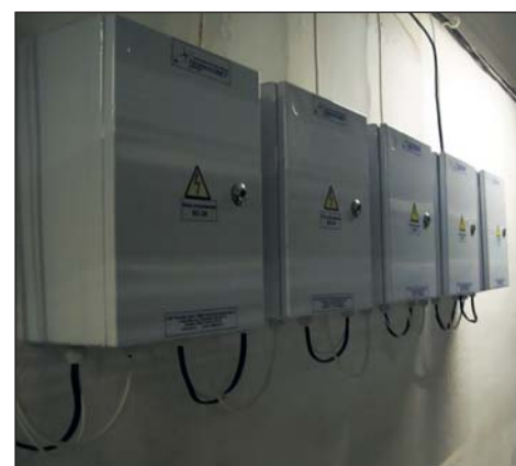
Рис. 8. Блоки сопряжения из состава светодиодной системы освещения ИСО «Хамелеон». Металлический шкаф обеспечивает оптимальный температурный режим работы электронного оборудования для максимального продления срока службы
