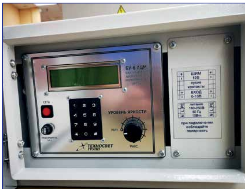
Рис. 6. Блок управления светодиодным освещением БУ-6АЦМ
